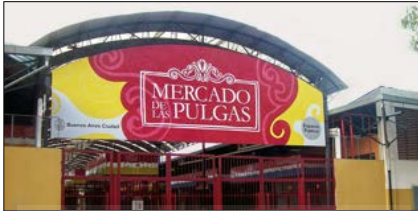
Fachada Mercado de pulgas - 2019
