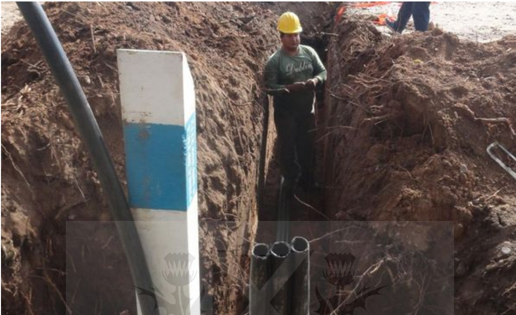
Imagen N.º 3: Tritubo de fibra óptica en obra de zanjado y canalización
