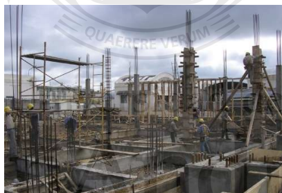
Imagen 6: Obra planta Atanor
