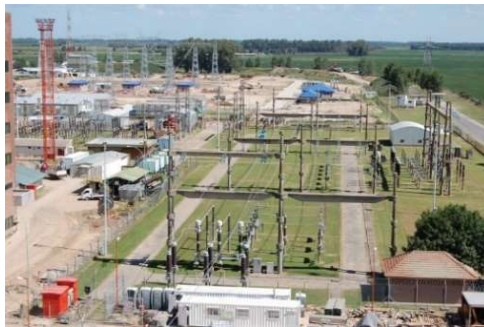
Imagen 5: Obra central nuclear Atucha
