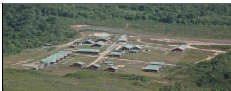
Foto 1 – Vista aérea del 4° PEF – Surucucu (RR) 22
