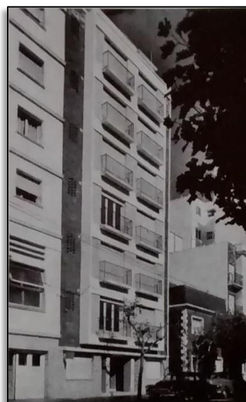
Edificio "Horizonte" / Luis Scheggia y Hno. y E. Bartolucci e Hijos (1952)
