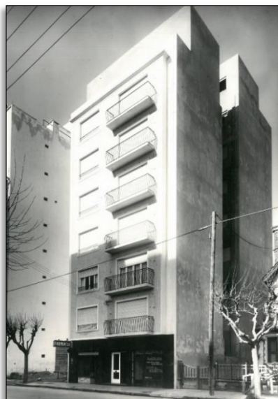
Ing. Blanco/ Edificio “Blanco I” (año 1952)
