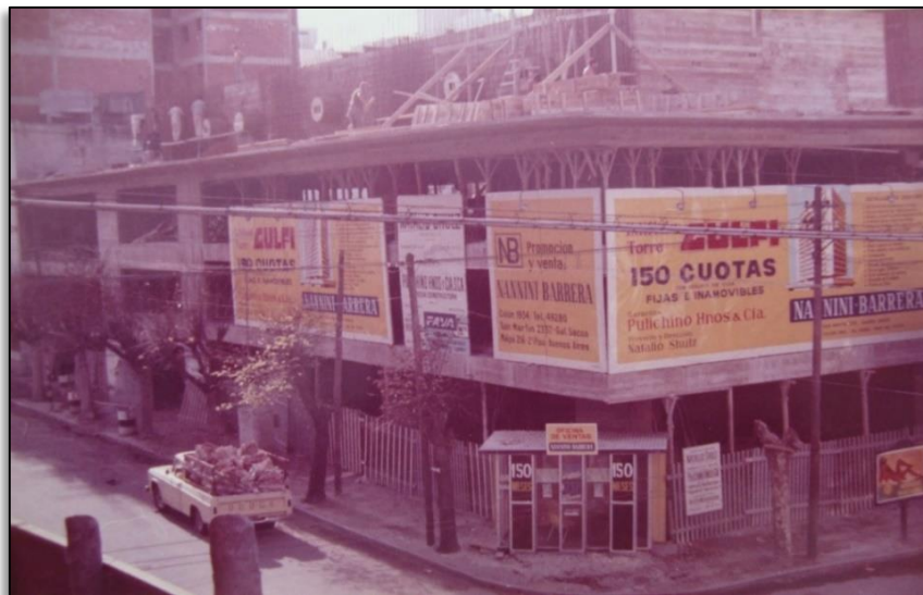
Foto 46. Torre Gulfi I en construcción, circa 1970
