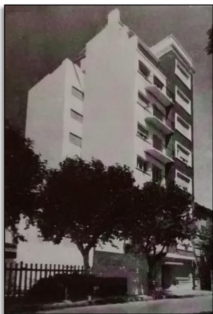
Edificio “Daver” (año 1952)
