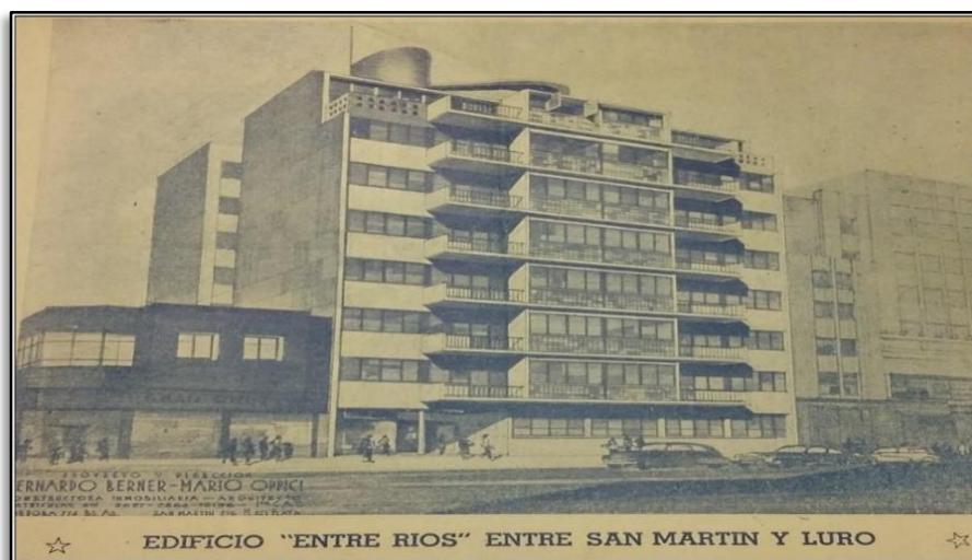
Foto 14. Primer edificio en PH construido en Mar del Plata, (Año 1949, Berner y Berner SA )
