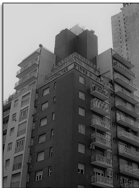
Edificio “Mondave” (año 1956)
