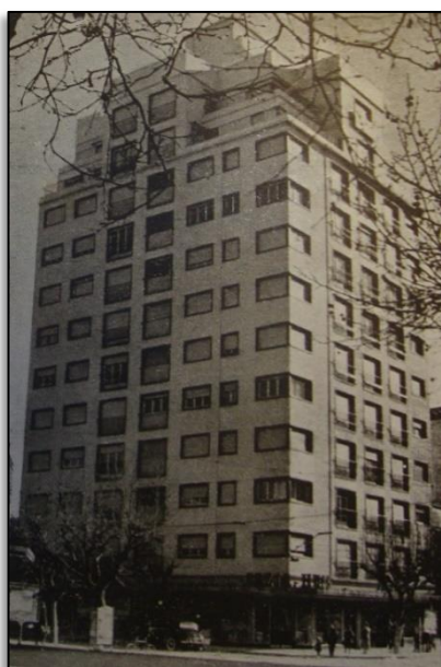
Edificio “El tronador” (año 1956)
