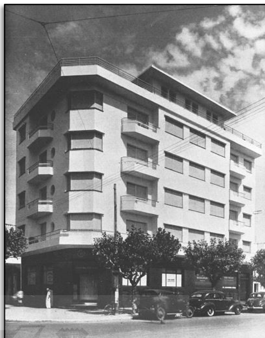
Edificio de renta, año 1940
