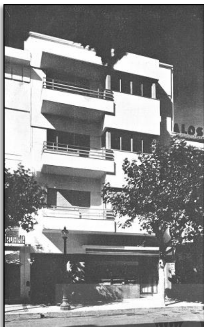
Edificio de renta, año 1938
