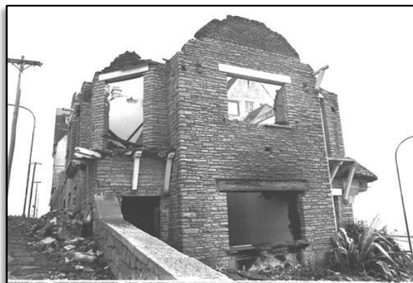
Demoliciones en el centro y en el Hotel Rotterdam (1970 o )
