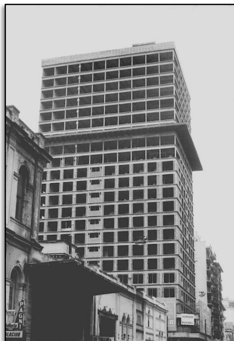
"Torre Odeón" (en construcción, año 1972)
