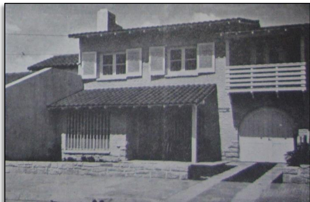
Residencia de verano, constructor Carmelo Pulichino (1945)
