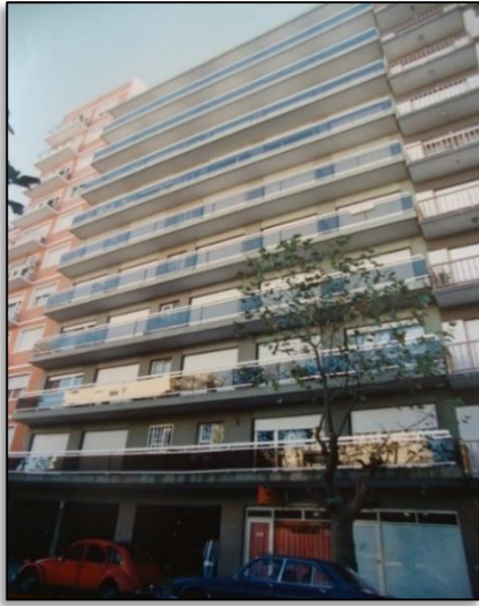
Foto 45. Edificio Gulfi XVIII
