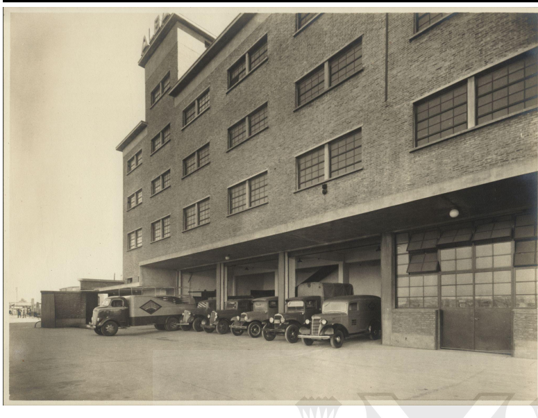
Fig. 5. ALBA S.A. Fábrica de esmaltes, pinturas y barnices. (1925-). Fuente: ABB - Banco fotográfico.
