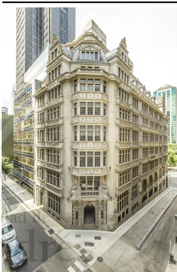
Fig. 1. Edificio Bunge y Born. Fuente: ABB - Banco fotográfico.
