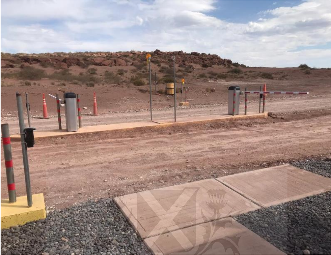
Construcción de Plataforma Convencional 3. Fuente: El equipo emprendedor.
