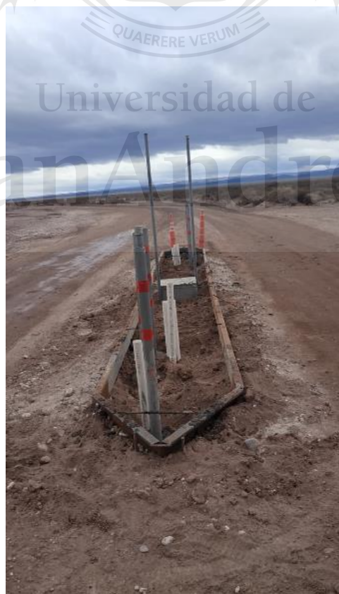
Construcción de Plataforma Convencional 2. Fuente: El equipo emprendedor.
