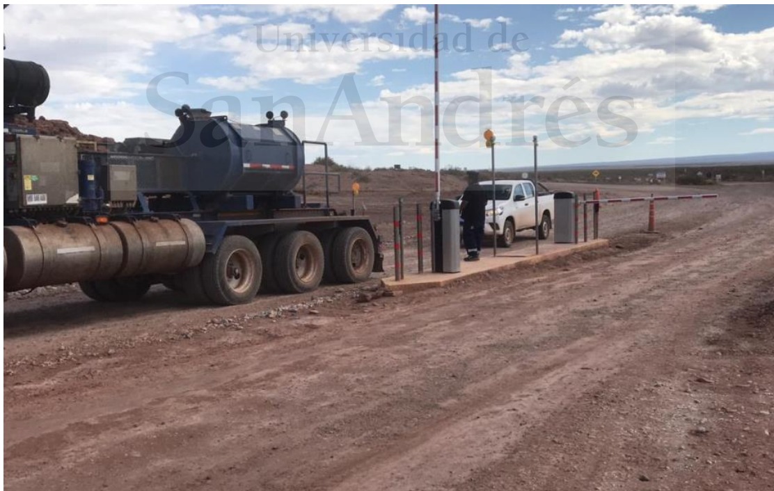
Construcción de Plataforma Convencional 4. Fuente el equipo emprendedor.
