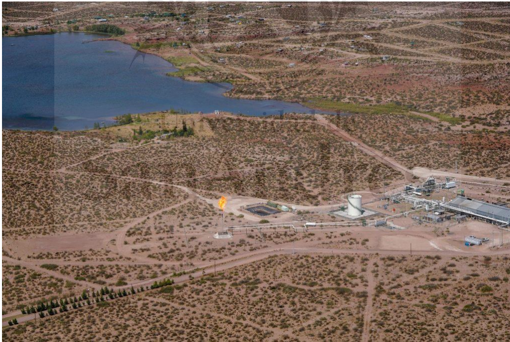
Caminos y Accesos a Explotación 1
