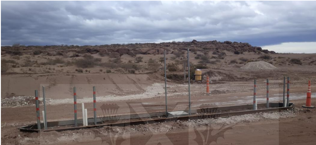
Construcción de Plataforma Convencional 1. Fuente: El equipo emprendedor.
