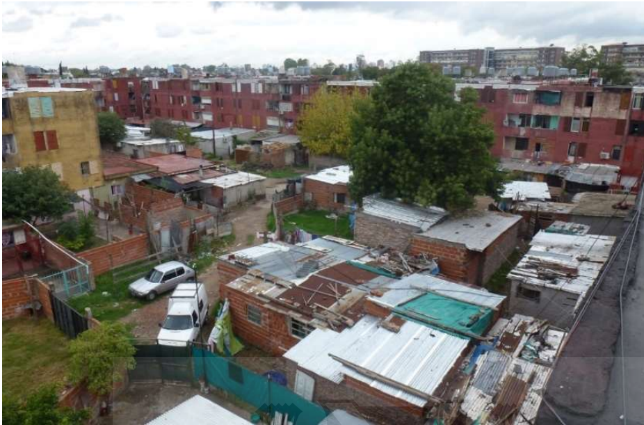
Imagen 15. Expansiones precarias sobre espacios de uso común en el CHPS
