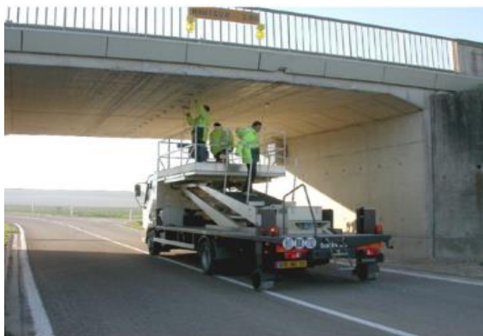
Fig. 14 - Instalación de sistema B-WIM - Fuente ISWIM
