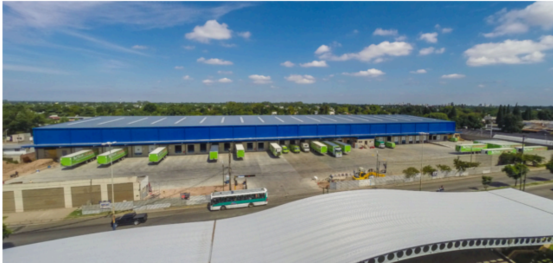
Figura 2. Nave terminada de Vía Cargo, Pablo Nogués, enero 2019.
