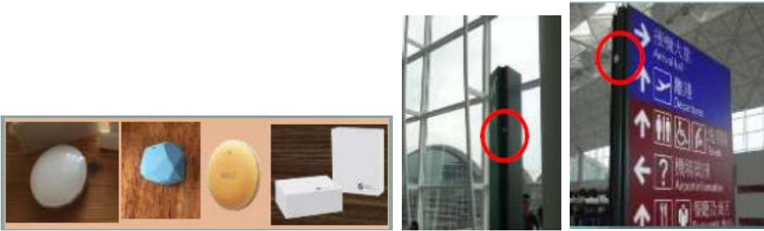
Fuente: Passenger Terminal Conference Ejemplo de beacons y la instalación de los mismos dentro de la terminal. (2017)
