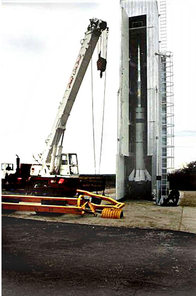
Córdoba II dentro de la torre de servicio vertical con las puertas abiertas. Cortesía Machtres.
