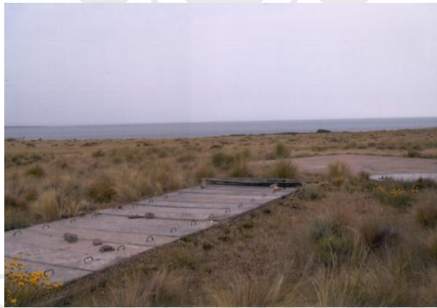
Pad de concreto para la torre de lanzamiento del Cóndor II. Los paneles de cemento son para proteger los cables que iban desde la torre de lanzamiento a la estructura de hormigón del centro de control. Cortesía Andrés Jozwicki.
