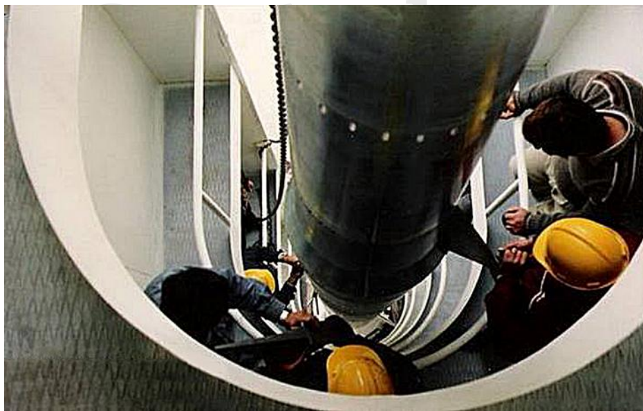
Técnicos trabajando en la unión entre la primera y segunda etapa del Cóndor II. La torre de servicio permitía el acceso desde una escalera colocada afuera.
