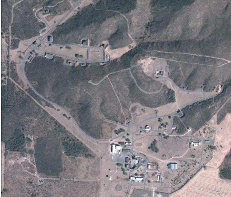
Imagen satelital de una sección de la planta de Falda del Carmen, Córdoba. Fuente: Google Maps.
