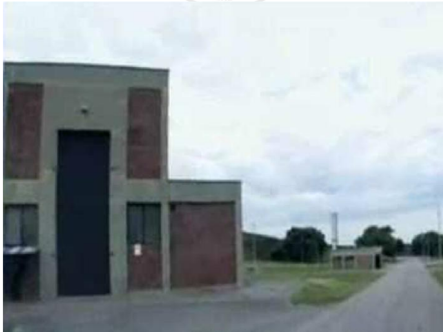
Algunos edificios de la planta de Falda del Carmen poseen largas puertas verticales para la salida de etapas completas de cohetes (Imagen de video).
