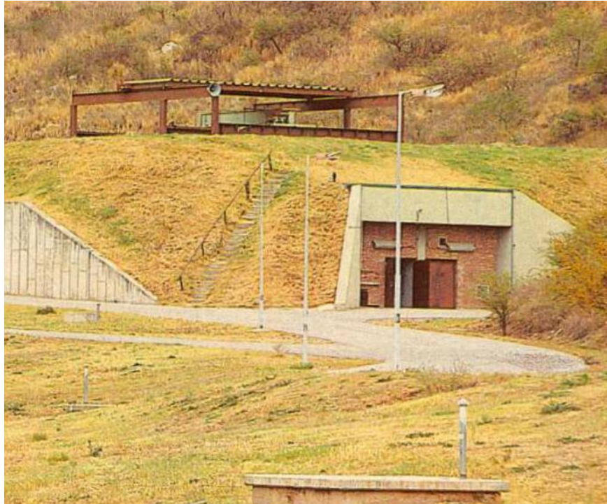
Edificio protegido contra explosiones en la planta de Falda del Carmen. Cortesía Museo Universitario de Tecnología Aeroespacial.
