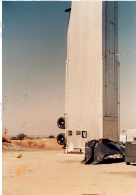
Acoplado/torre de servicio vertical que albergaba al Cóndor II durante las operaciones de tierra. La misma había sido desarrollada por una fábrica de carrocerías de colectivo en Córdoba. Fuente protegida.
