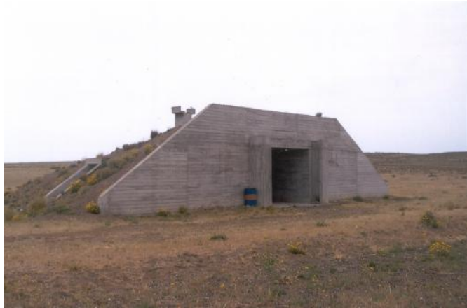
Instalaciones de lanzamiento en Cabo Raso, provincia de Chubut. La estructura de hormigón recubierta con tierra (blockhouse) iba a albergar al control del misil. Cortesía Andrés Jozwicki.
